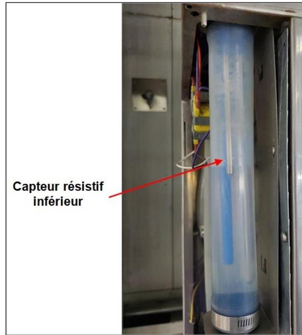
**Étape 5.** La sonde de niveau d'eau va ensuite commencer à se remplir jusqu'à temps que le niveau atteigne le capteur résistif supérieur. L'opération de remplissage automatique peut être arrêtée à n'importe quel moment en appuyant et maintenant sur Enter ✓ pendant 3 secondes.
